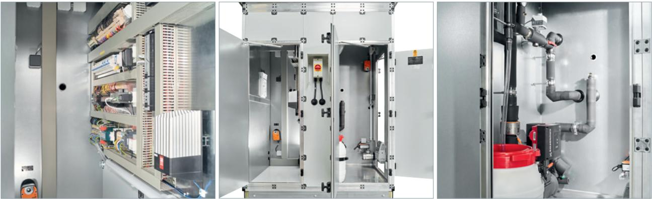
Die Regelung des Lüftungsgerätes und die Hydraulik der Wärmerückgewinnung sind innerhalb des Gerätes in zwei getrennten Kammern außerhalb des Luftstroms untergebracht.
